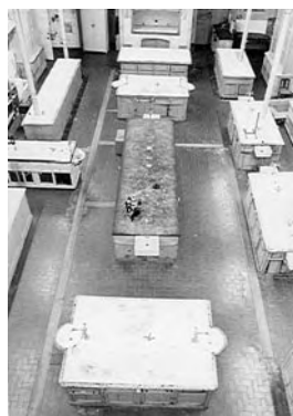
Figura 8 Laboratório Chimico antes da recuperação (1998).
