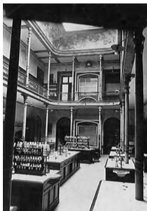
Figura 5 Laboratório Chimico depois das obras de remodelação efectuadas por José Júlio Rodrigues (cortesia do Serviço de Biblioteca e Documentação, Museu de Ciência da Universidade de Lisboa)
