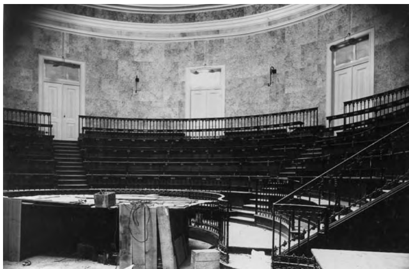
Figura 4 Fotografia de F. Rocchini do Anfiteatro durante as obras de remodelação efectuadas por José Júlio Rodrigues (cortesia do Serviço de Biblioteca e Documentação, Museu de Ciência da Universidade de Lisboa).
